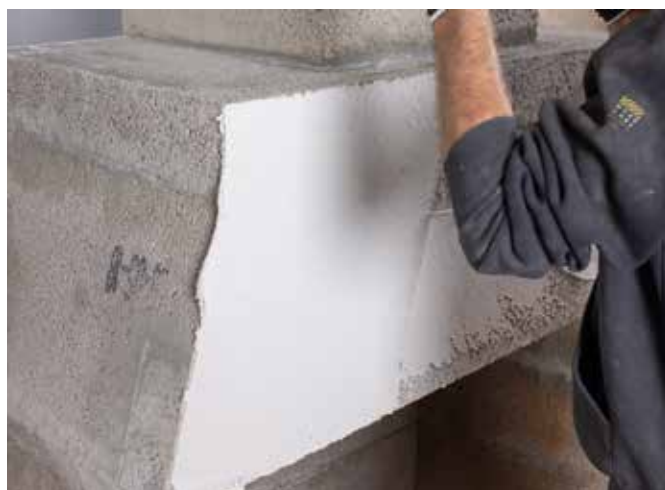
3. Putsa de yttre ytorna.
